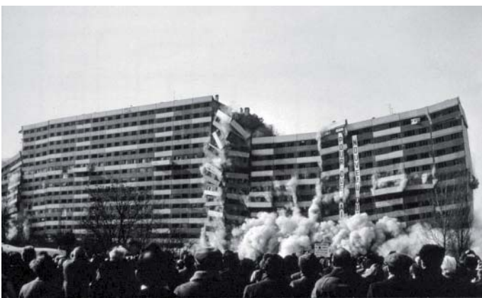
G. Crossay, « Cité des 4000, démolition de l'immeuble Debussy, 18 février 1986 », coll. ministère de l'Égalité des territoires et du logement / ministère de l'Écologie, du développement durable et de l'énergie - https://territoiredesimages.wordpress.com/2014/04/08/les-grands-ensembles-cinquante-ans-d'une-politique-fiction-francaise/
