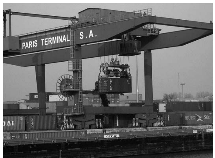
Portique de manutention pour conteneurs au port de Gennevilliers (photo Lundeux, 2006)
